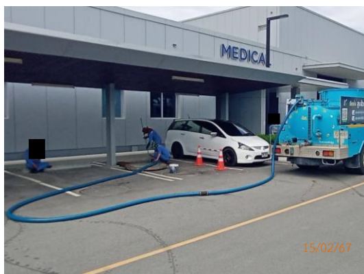
รูปที่ 3-38 การสูบน้ำทิ้งที่มีค่าไม่ผ่านมาตรฐานเพื่อนำไปกำจัด โดยบริษัทรับกำจัดสิ่งปฏิกูล
